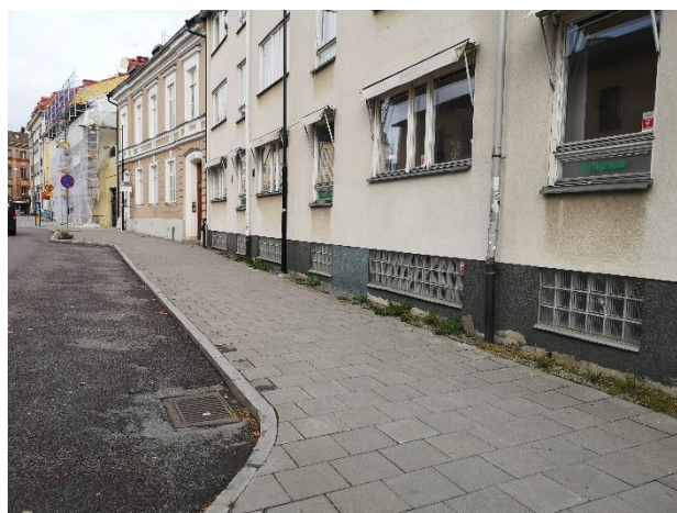
Fönster mot gatan i nivå med trottoaren
