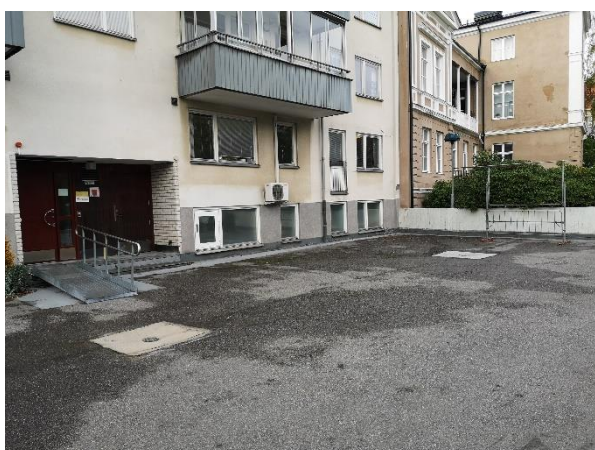
Entré från gården med fönster i markplan
